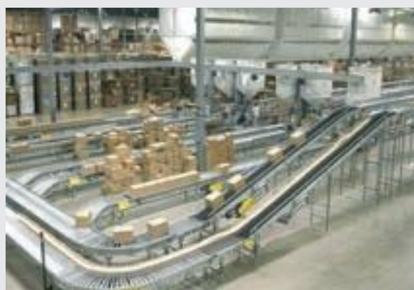
Автоматизированное складское оборудование
