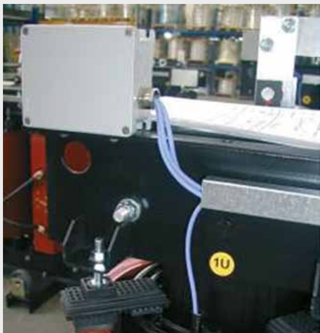
Пример установки блока контроля температуры с датчиком Pt 100
