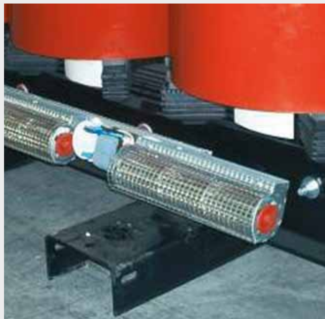
Радиальные вентиляторы трансформатора с литой изоляцией
