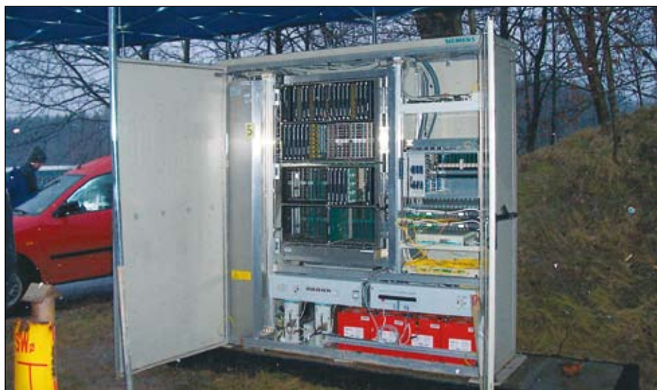
Шкаф перед реконструкцией
