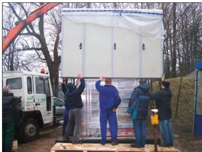
Шкаф в период реконструкции
