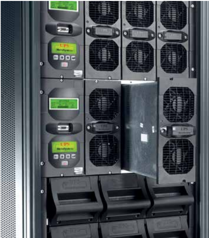
Блочная модульная архитектура позволяет заменять отдельные элементы, не прерывая работы всей системы.
