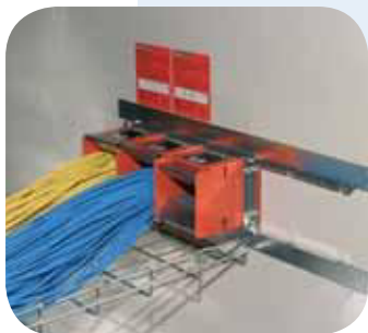
► ПРОХОД КАБЕЛЬНОЙ ТРАССЫ ЧЕРЕЗ СТЕНУ ПРИ ПОМОЩИ УНИКАЛЬНЫХ ОГНЕСТОЙКИХ МОДУЛЕЙ EZ-PATH
